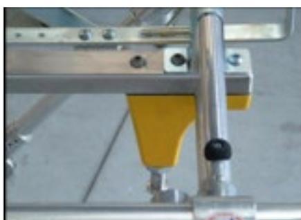
Figura 11: Dettaglio morsetto posteriore con monoperno.
